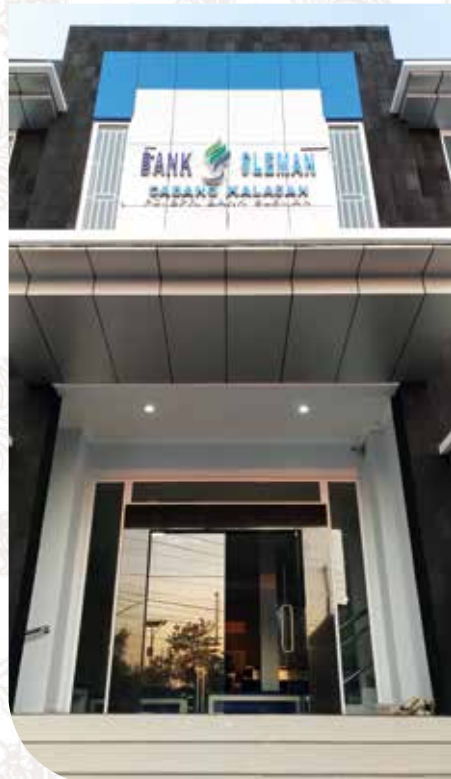
Penyelesaian pembangunan Kantor Cabang Kalasan yang beralamat di Jalan Raya Jogja-Solo Km. 15 Tamanmartani. Bangunan Gedung Kantor Cabang Kalasan didirikan di atas tanah milik sendiri dengan luas 374 m2 terdiri dari 2 lantai. Pembangunan gedung dilaksanakan oleh CV. Sumber Teknik
